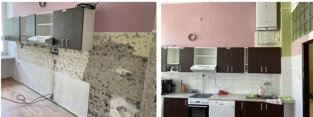
Foto žákovské kuchyňky na hlavní budově před a po rekonstrukci.
